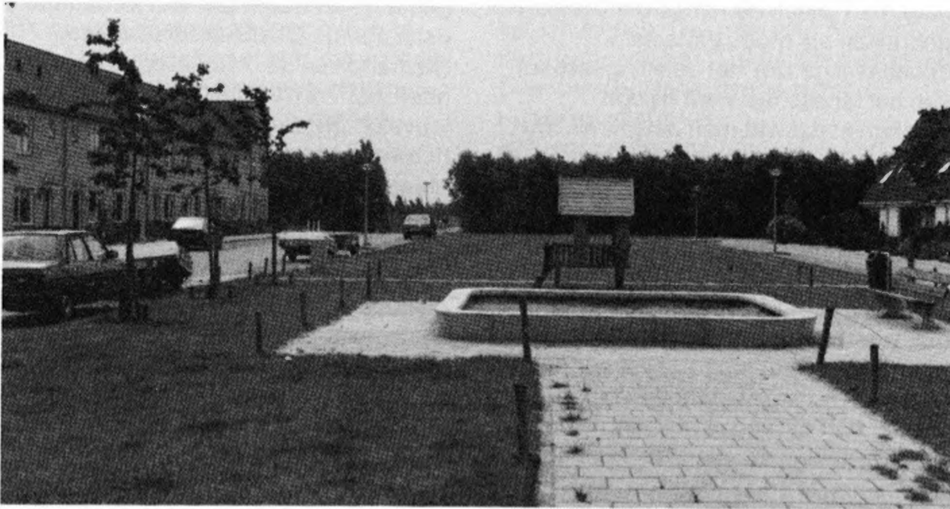
De Bouwmeesterbuurt, grenzend aan het vooringeplante Bouwmeesterpark, juist na de oplevering.
